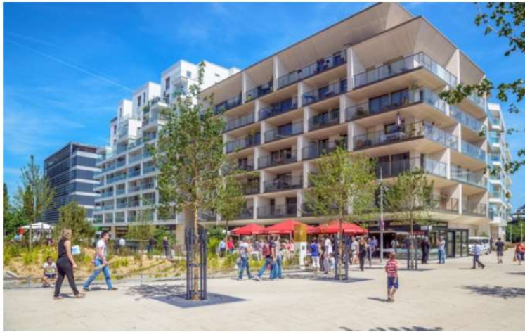
Ecoquartier des Bords de Seine à Issy-les-Moulineaux. © Fabrice Boissière
